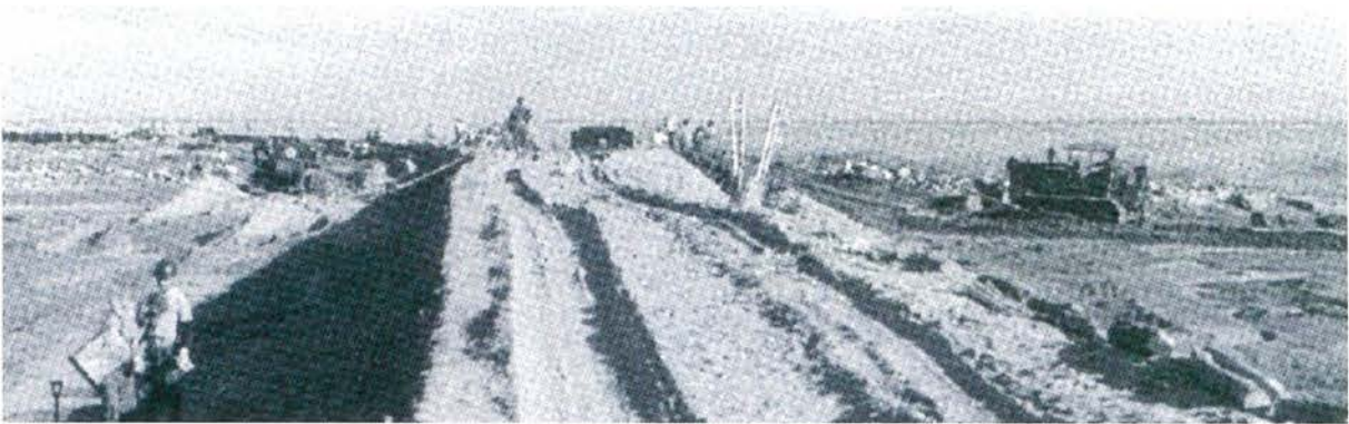
海岸堤防復旧工事のようす（当時撮影）
