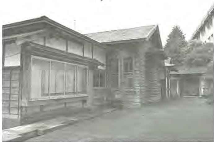
旧津島家新座敷（五所川原市金木町）
