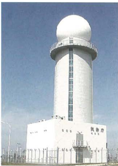
空港に設置している ドップラーレーダー
